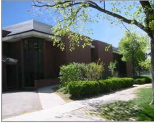
Wasatch Elementary – remodelación y adición
