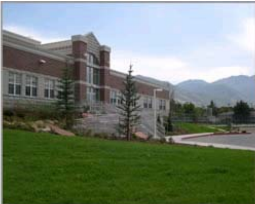
Dilworth Elementary – reconstruída
